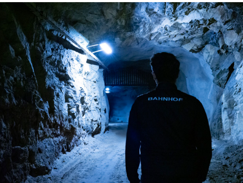
I Göteborg förvandlar Bahnhof ett enormt bergtrum till datacentret Bahnhof Bunker.
